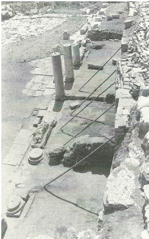
Figura 4: Portico occidentale dell'agora di Sagalassos (Putzeys 2008)
