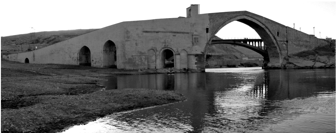
Figura 33 - Diyarbakır, Silvan, Batman Suyu Köprüsü. Prospetto meridionale.
