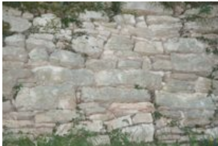
d. Muro a secco
