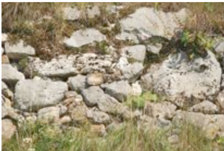
c. Muro a secco
