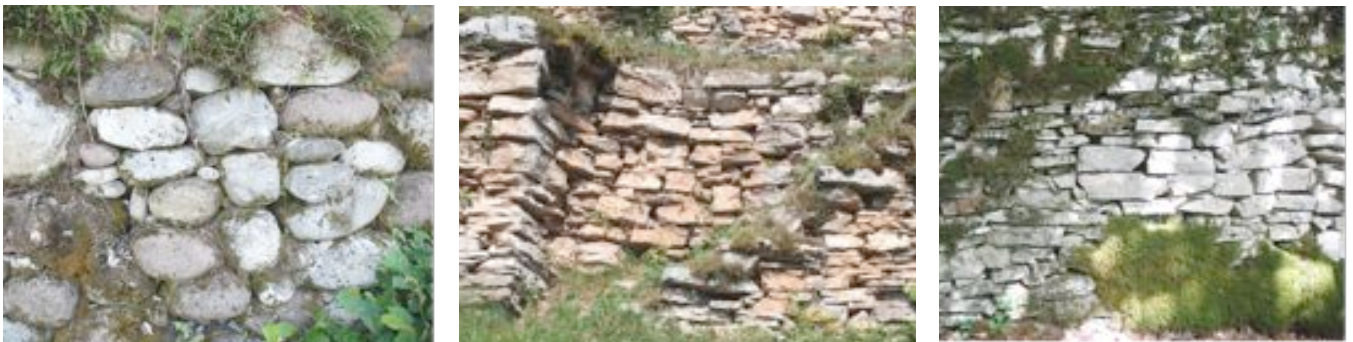
Fig. 32: esempi di differenze nei materiali litoidi utilizzati per la costruzione dei muri a secco nell'area di studio. A partire da sinistra: materiali morenici con litologia mista di natura metamorfica e vulcanica con evidente arrotondamento dovuto al trasporto precedente la deposizione (località Terna, Comune di Sovramonte); calcari marnosi rossastri (località Salzen, Comune di Sovramonte); calcari bianchi (località S. Felice, Comune di S. Gregorio).
