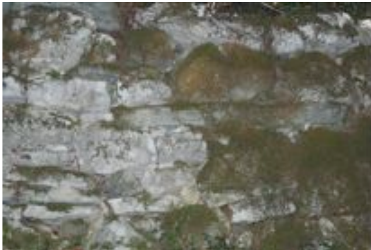
e. Muro a secco
