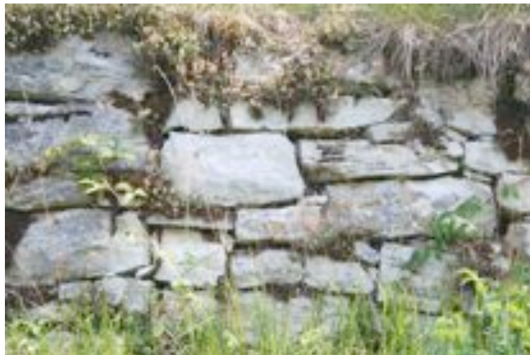
c. Muro a secco con scaletta
