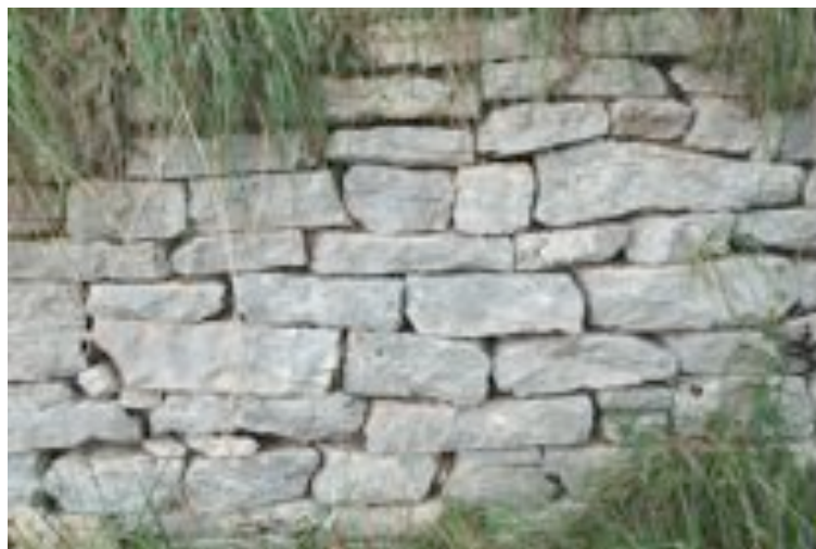
a. Muro a secco
