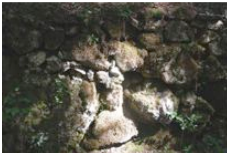
d. Muro a secco
