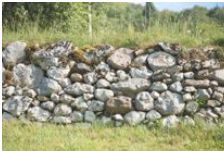
e. Muro a secco
