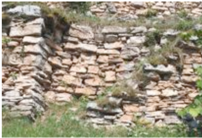
a. Muro a secco con scaletta
