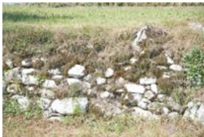
e. Muro a secco
