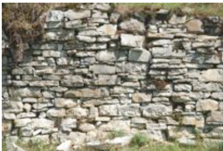
e. Muro a secco
