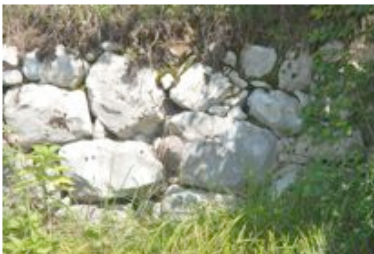
c. Muro a secco
