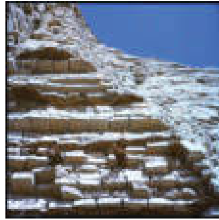
Foto 986 - [8.22] Ugo Sissa, Mattoni di Aqar Quf con stuoie , [esec. 195?].
