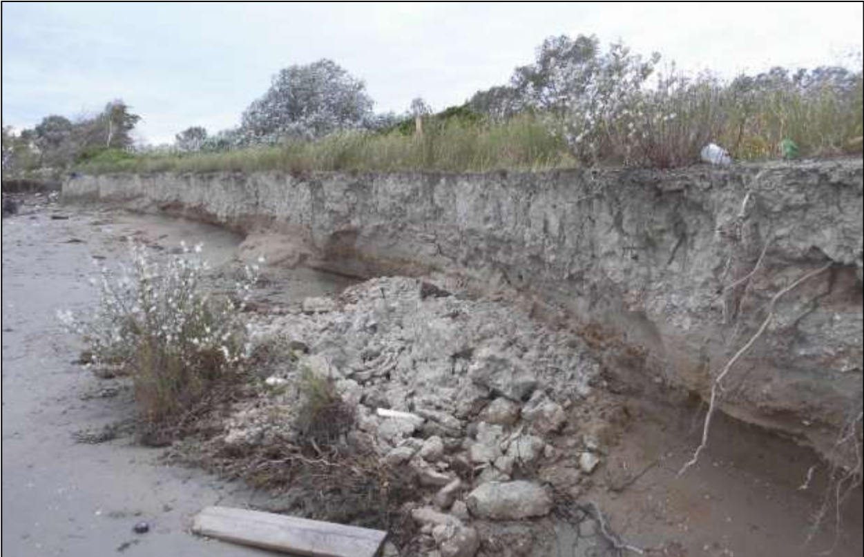
Figura 81. Scarpata di erosione con crollo di materiale. Fotografia scattata lungo il margine della cassa di colmata B.
