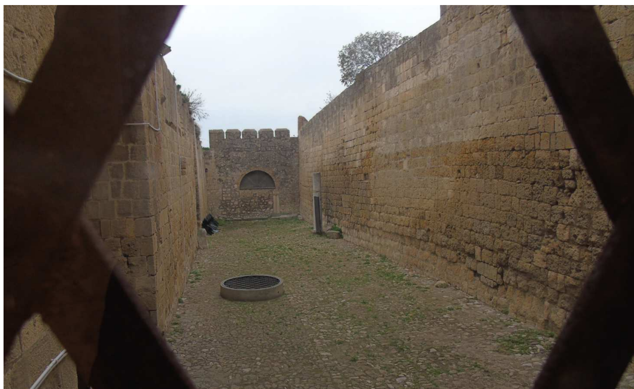
Fig. 30 - Sezione delle doppie mura trecentesche di Corneto; elaborazione grafica da Chiovelli, Tecniche costruttive murarie medievali... , p. 197. Un possibile modello per questo tipo edilizio consiste nelle mura della città crociate: un esempio nella pianta di Acri di Pietro Vesconte riportata qui di seguito, nella quale le doppie mura sono accuratamente riprodotte.
