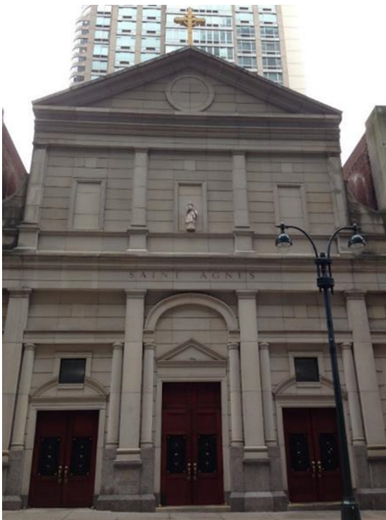
Figura 10 Facciata della Chiesa di St. Agnes, oggi incastonata fra i grattacieli di Manhattan.
