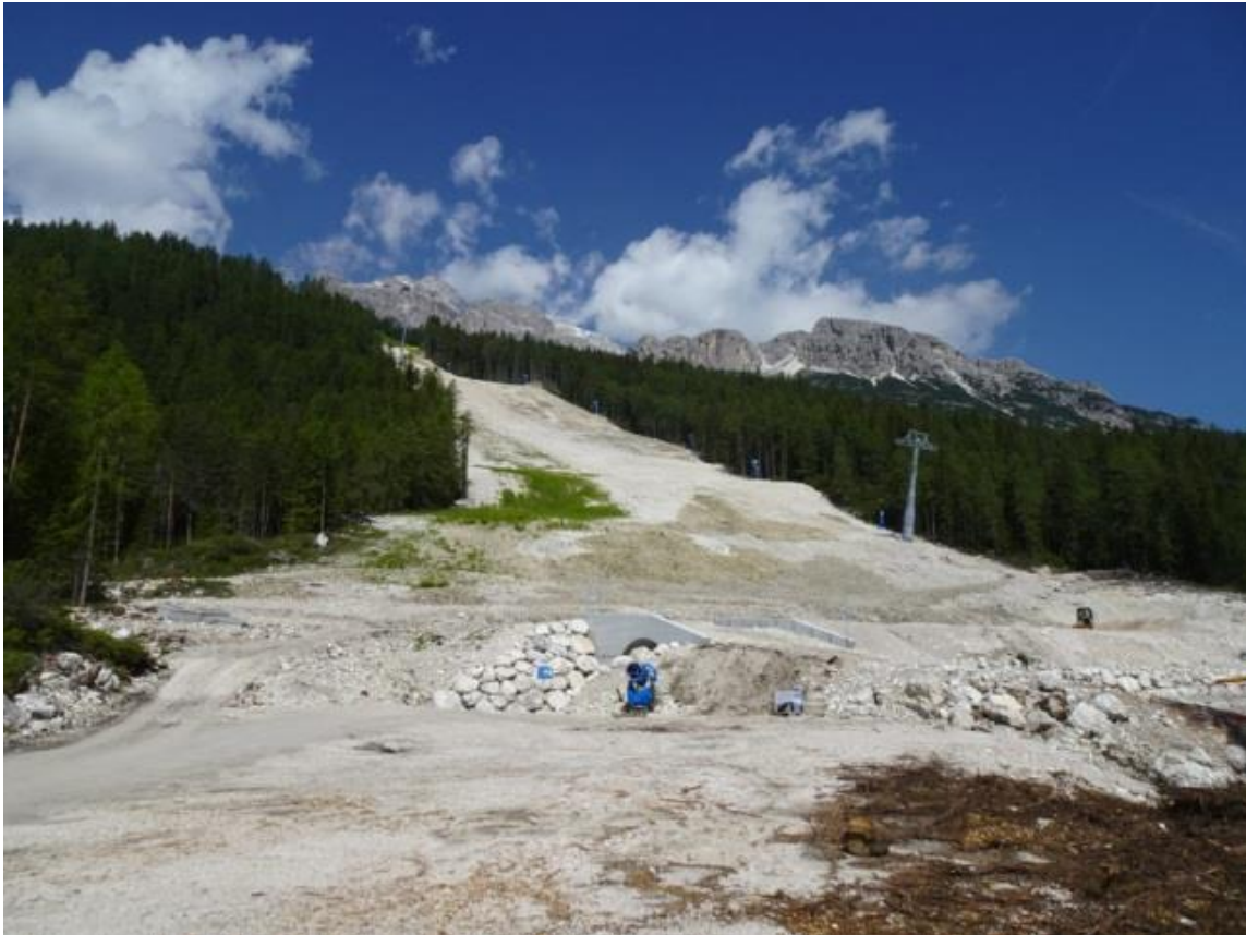
29. Cortina: lavori di sbancamento e allargamento della pista dello slalom speciale.
