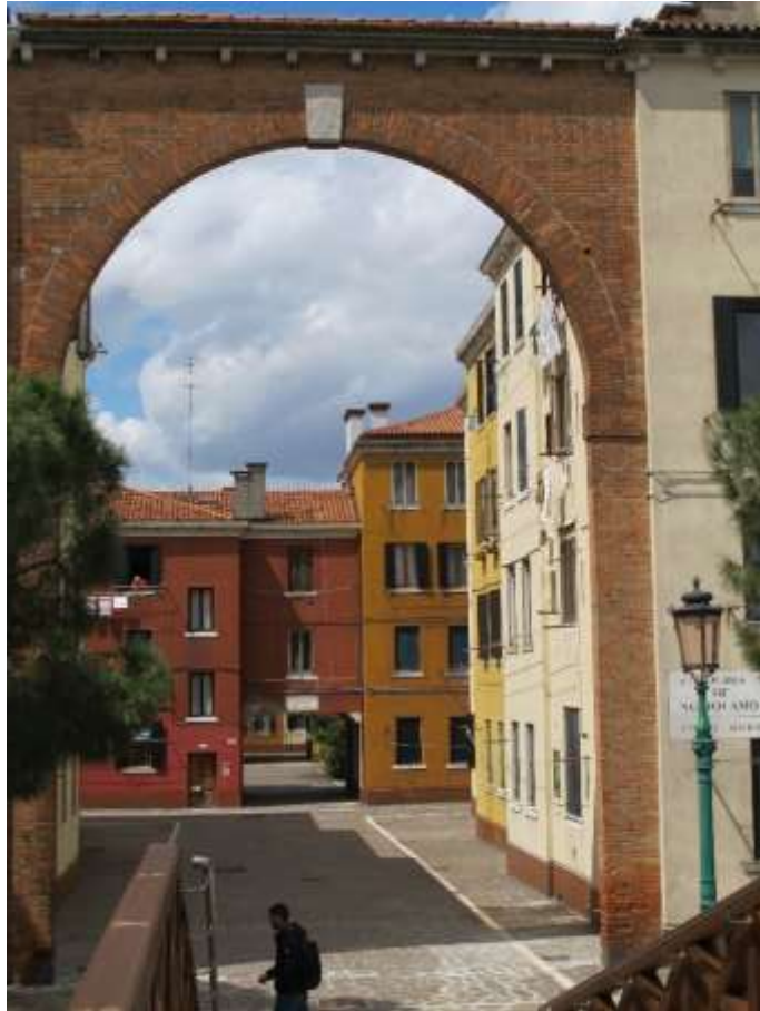
Abb. 139, San Girolamo, Fondamenta Carlo Coletti, Quartierseingang, Foto J. Fichte 2017
