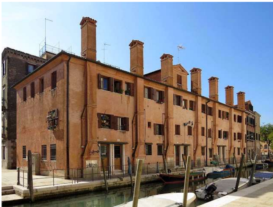
Abb. 16, exemplarischer Wohnungsbau aus dem 18.Jh, Fondamenta Tron Santa Marta, 2010, https://dailyphotostream.blogspot.com/2013/12/house-of-seven-chimneys.html (Zugriff (16.08.2020))
