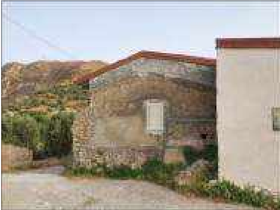
RC_H224_MA030: Pellaro, Chiesa di San Filippo di Jiriti – Edifici moderni costruiti su resti architettonici antichi (ph. Sara Bini)
