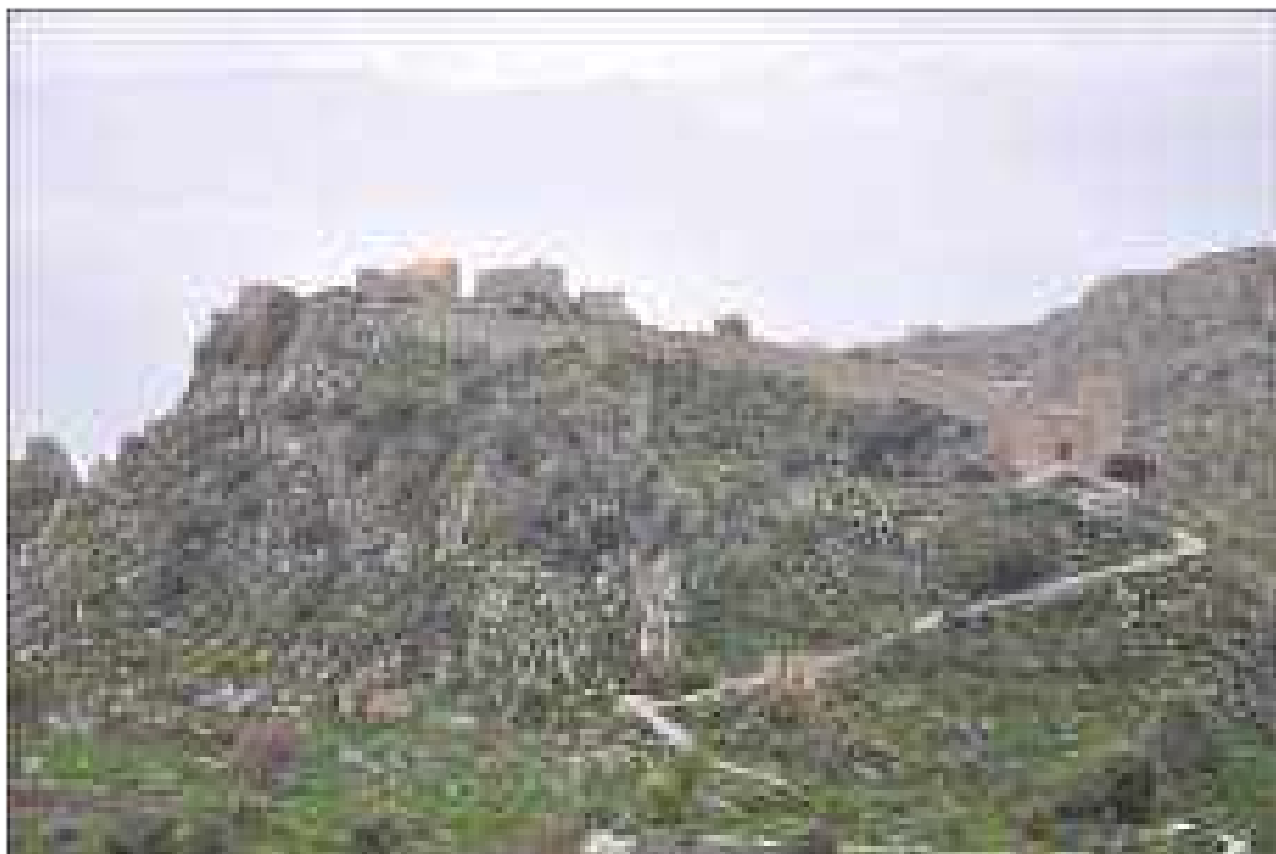
RC_F779_CA001: Motta San Giovanni, loc. S. Niceto – Il castello dopo i restauri visto dall'esterno (ph. Carlo Scuderi)
