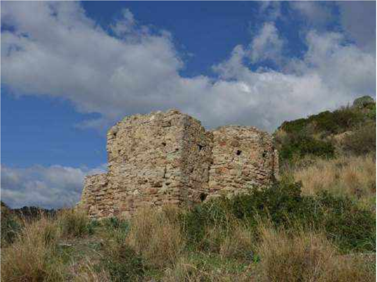
RC_B099_MA008: Bova Marina, loc. Vena – I resti della chiesa di S. Niceto di Apambelo (Archivio Fotografico SABAP RC-VV)
