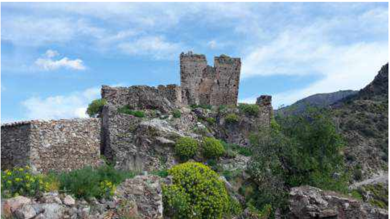
RC_C954_CA002_MA007: Condofuri, loc. Amendolea – I resti del castello con il mastio quadrangolare (ph. Sara Bini)
