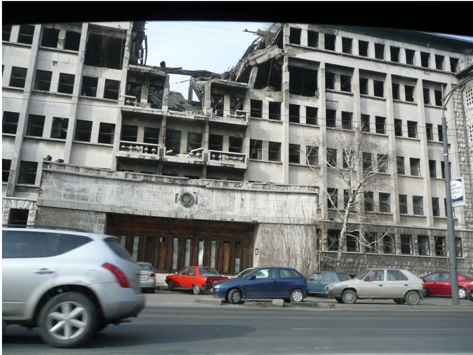
Edificio del Ministero della Polizia di Belgrado bombardato (Foto Luca De Poli 2009)
