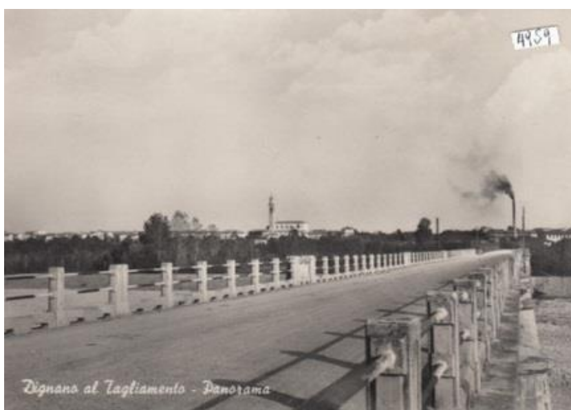
Visuale del ponte in direzione di Dignano in una cartolina d'epoca
