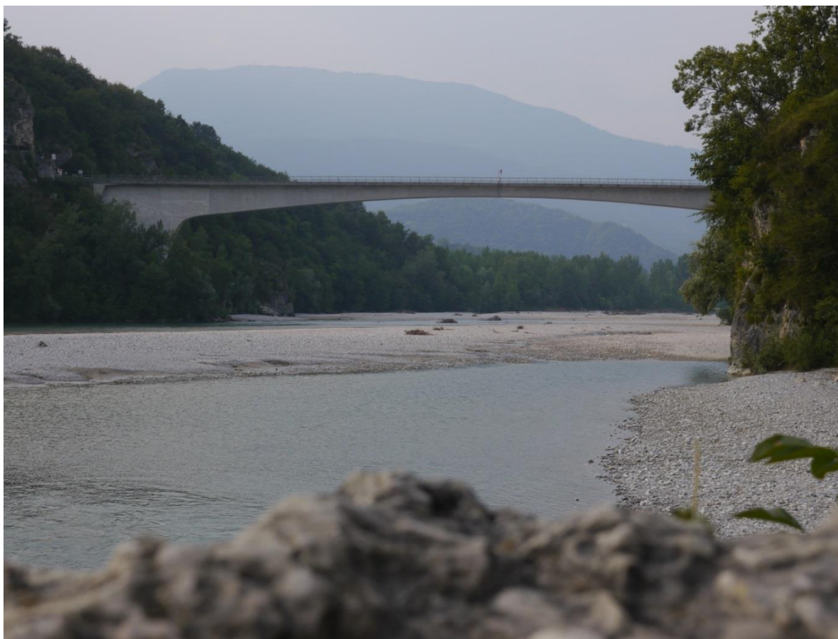
Visuale del Ponte di Pinzano dal letto del Tagliamento
