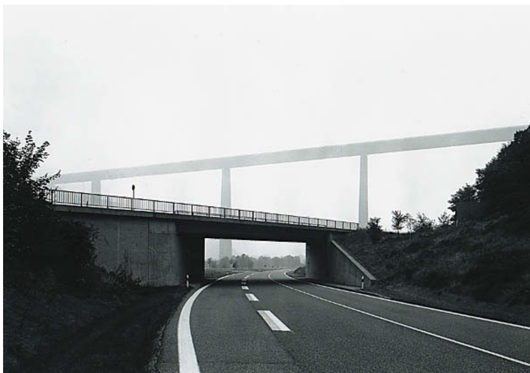
48. Moselbrücke bei Koblenz, 1979.
