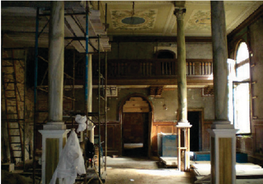
Fig. 1 Sala detta del «fascio» durante le fasi di restauro (2012)
