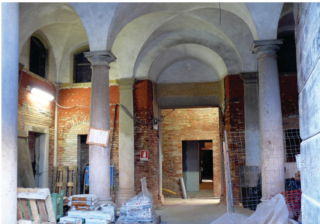
Fig. 12 Vestibolo di accesso dalla porta d'acqua durante le fasi di restauro (2012)
