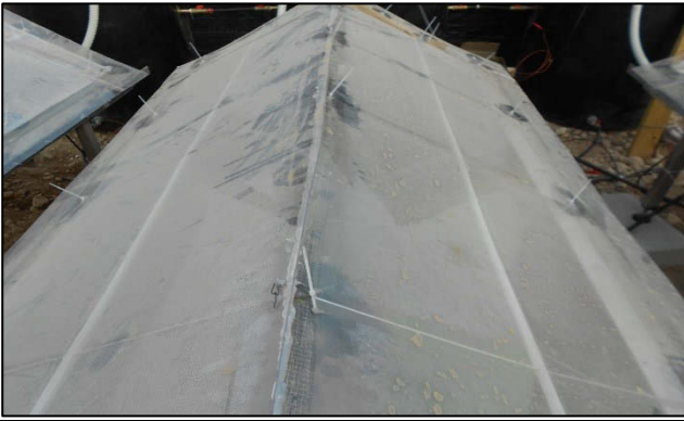
Copertura in policarbonato da 3 mm
