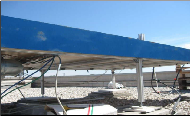
Struttura di sostegno della serra solare in alluminio
