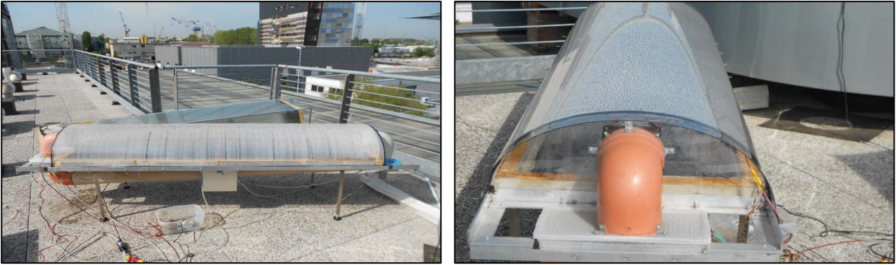
Figura 8 – Immagini della serra solare installata presso i laboratori di scienze dei materiali dell’Università Ca’ Foscari di Venezia, utilizzata per la validazione del modello exergetico
