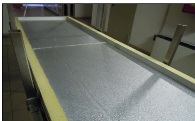
Strato di isolamento termico (Poliisocianato da 4 cm con K=0.024 \text{ W/m K} )
