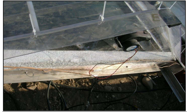
Strato di isolamento termico (polistirolo compresso da 4 cm con K=0.027 W/m K)
