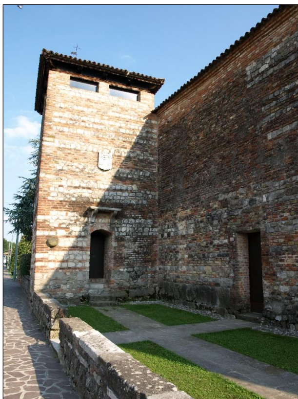
Fig. 15 Torre "campanaria" dell'Oratorio di S. Croce
