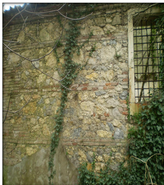
Fig. 4 Pieve S. Giustina di Montegalda, muro perimetrale sud (a sinistra) e muro perimetrale a nord (a destra). La parete sud realizzata con una messa in posa di conci laterizi e lapidei malamente posizionati
