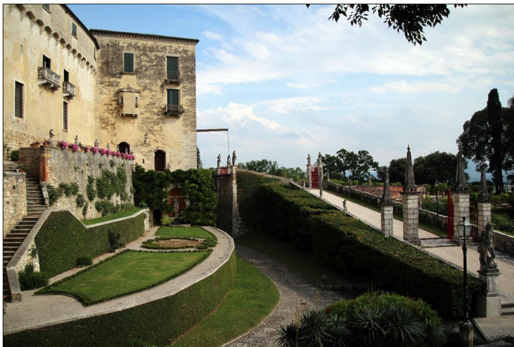
Fig.5 Castello di Montegalda, cortina esterna in cui vedono fossato, lizza, antemurale e scarpa totalmente rifunzionalizzati e trasformati in giardini.
