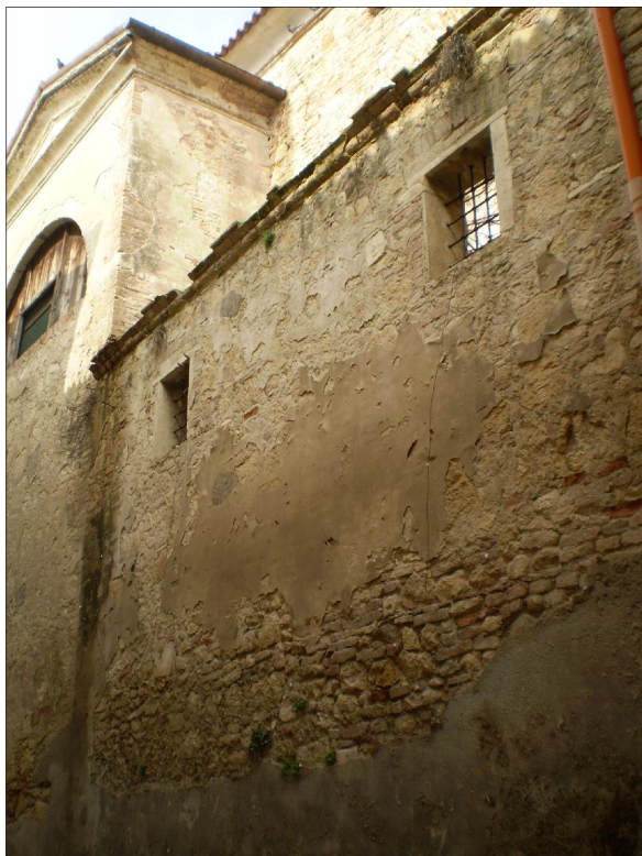
Fig. 4 Pieve S. Giustina di Montegalda, muro perimetrale sud (a sinistra) e muro perimetrale a nord (a destra). La parete sud realizzata con una messa in posa di conci laterizi e lapidei malamente posizionati
