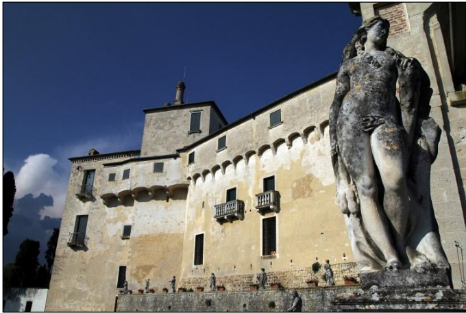
Fig. 6-7 Facciata sud del castello dove alla base si scorge la messa in opera a blocchi squadrati meglio visibili nel particolare a sinistra.
