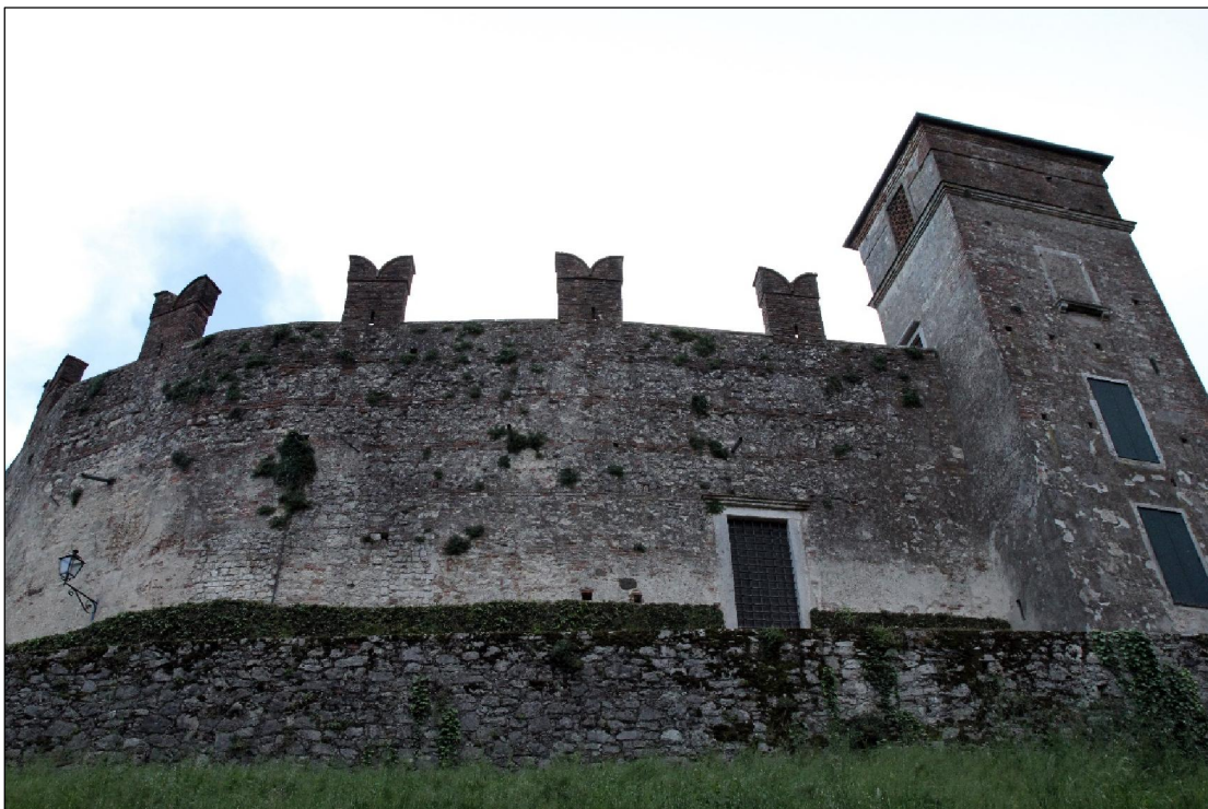
Fig. 8 Cinta muraria versante settentrionale rimasta libera dall'intonaco. Si notano le varie fasi della tecnica costruttiva dove nella parte inferiore ritorna la messa in opera abbastanza regolare formata da piccoli blocchi lapidei
