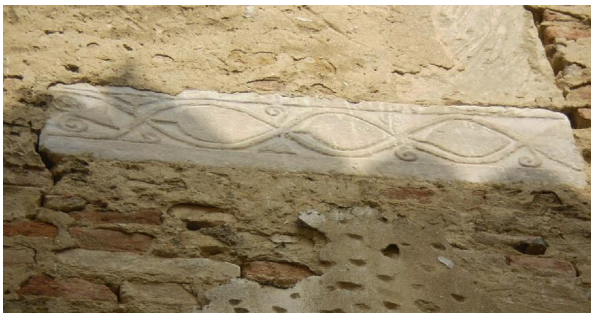
Fig. 7 Frammenti scultorei di reimpiego inseriti lungo le mura perimetrali nord (immagine in alto) e sud (immagine in basso).
