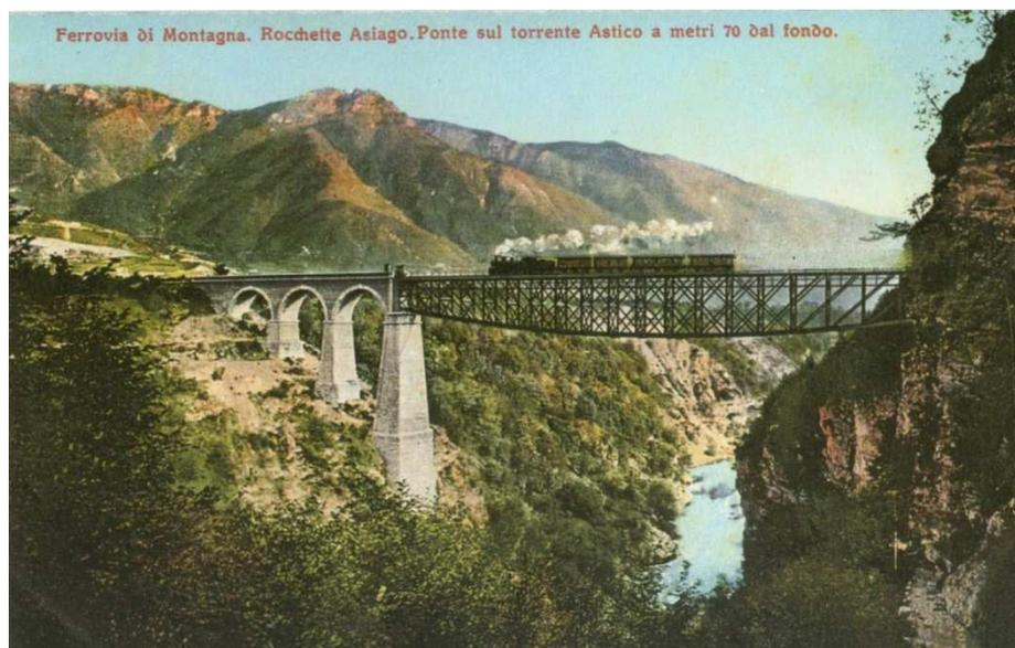
Figura 2.24: Una cartolina del 1912 che mostra il ponte ferroviario sull'Astico, costruito in muratura e ferro ad un'altezza di 70 metri e lungo più di 150. Rappresentava uno dei punti più pittoreschi dell'intero sistema ferroviario ideato dal Rossi in quel periodo e una delle opere più
