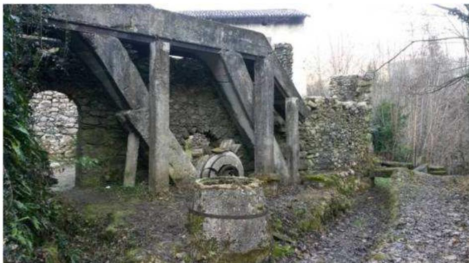
Figura 3.12: In quest'immagine si possono vedere i resti di un *maglio*, con la struttura che incanalava e faceva cadere l'acqua dall'alto, una specie di pozzo per lo sfiato d'aria e il solco della roggia.
