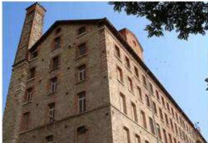
Figura 2.11: La Fabbrica Alta, divenuta simbolo dell'archeologia industriale del Veneto e di Schio stessa. Costruita sul modello delle fabbriche belghe ed inglesi, si estende per una lunghezza di 80 metri ed è composta da 6 piani;
