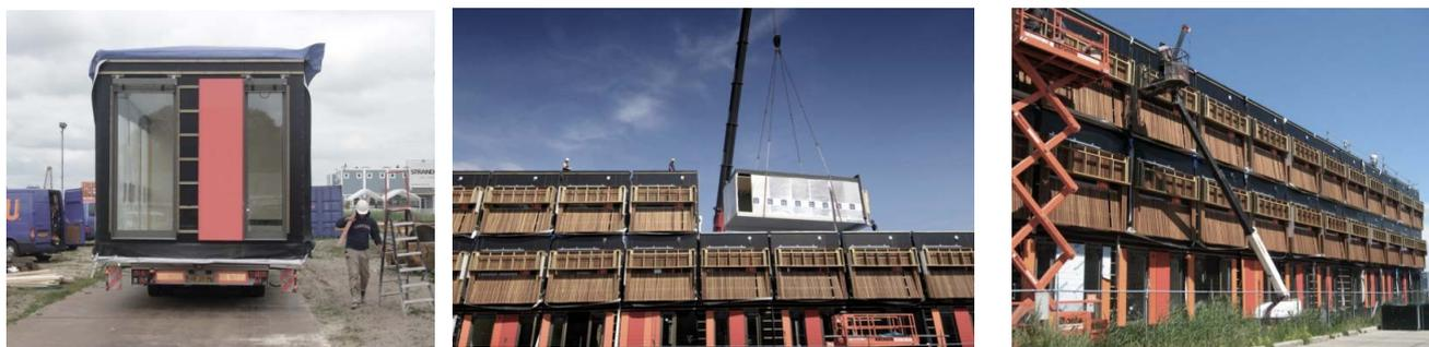
Fig 12.2 Fasi della prefabbricazione della scuola: trasporto dei moduli abitativi e loro progressivo montaggio.
