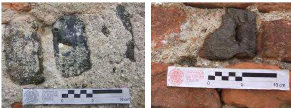
Fig. 85-86: dettaglio paramento in laterizi e segni di lavorazione su stipite.
