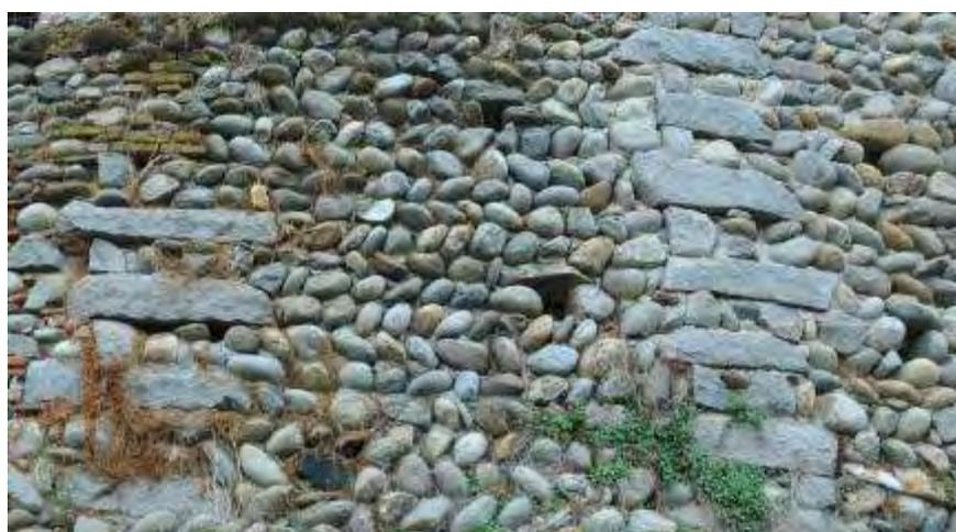
Fig.121: Candelo, Ricetto, particolare della muratura alla sinistra della torre di cortina.
