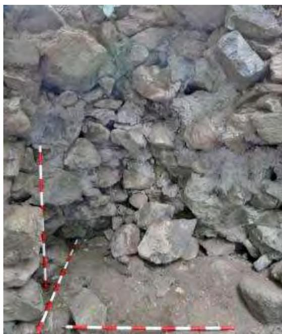
Fig. 238: dettaglio del "sacco" della muratura delle mura del "ricetto".
