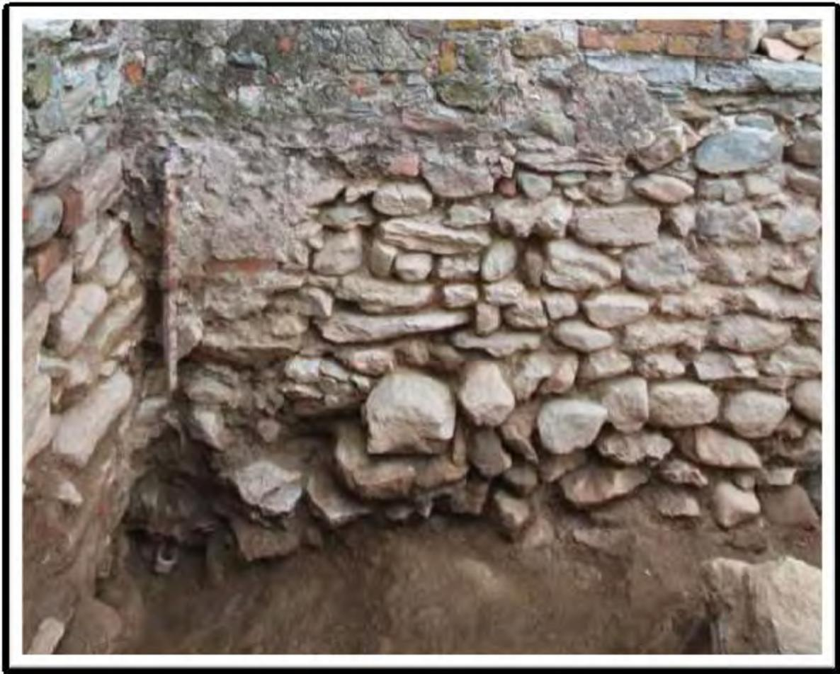
Fig. 276: dettaglio dell'angolo tra torre-porta e muro di cinta, con le due chiavi metalliche menzionate nel testo.
