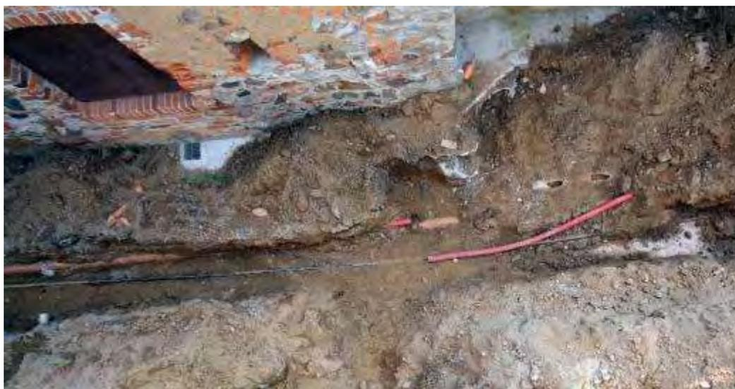
Fig. 263: fotografia zenitale di una sezione della trincea scavata; in evidenza le numerose tubature esistenti intercettate.
