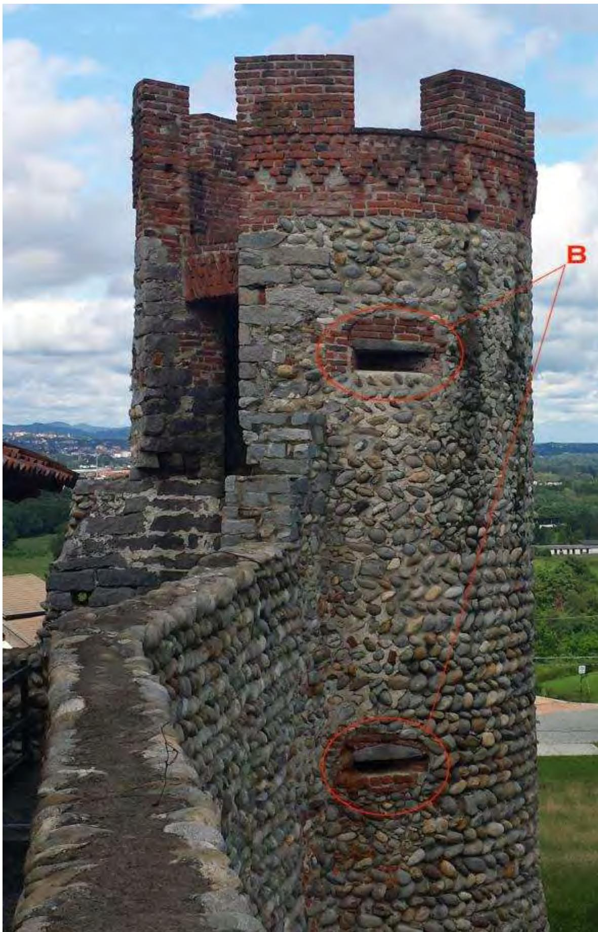
Fig. 119: torre sud-est del Ricetto di Candelo con indicazione delle tipologie di feritoie esistenti.
