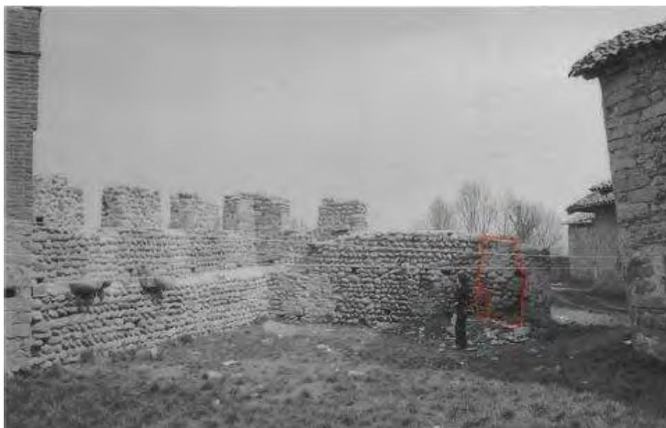
Fig. 155: Candelo, angolo nord-orientale del Ricetto, evidenziati in rosso la spalletta in laterizi e la muratura di chiusura dell'apertura (Fondo Viglino Davico, Centro Documentazione Ricetti del Piemonte – Comune di Candelo).
