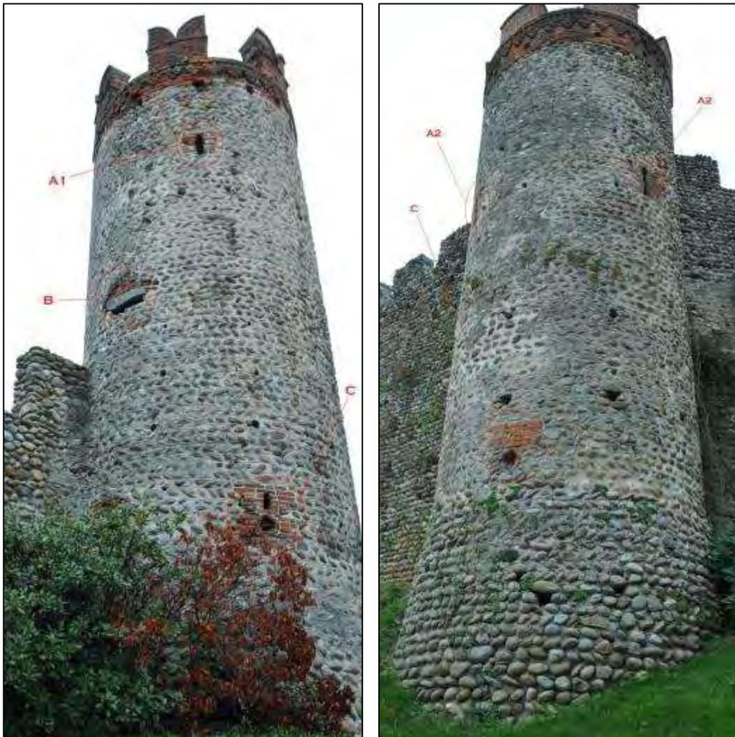
Figg. 117-118: torri sud-ovest e nord-est del Ricetto di Candelo con indicazione delle tipologie di feritoie esistenti.
