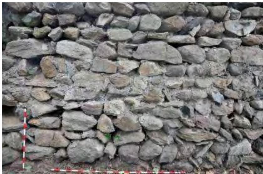
Fig. 237: dettaglio della tessitura muraria delle mura del "ricetto".
