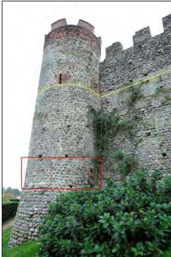
Fig. 146: Ricetto di Candelo, torre di nord-est; evidenziata in rosso la quota delle feritoie di tipo C, in giallo la quota attuale del terreno all'interno delle mura.
