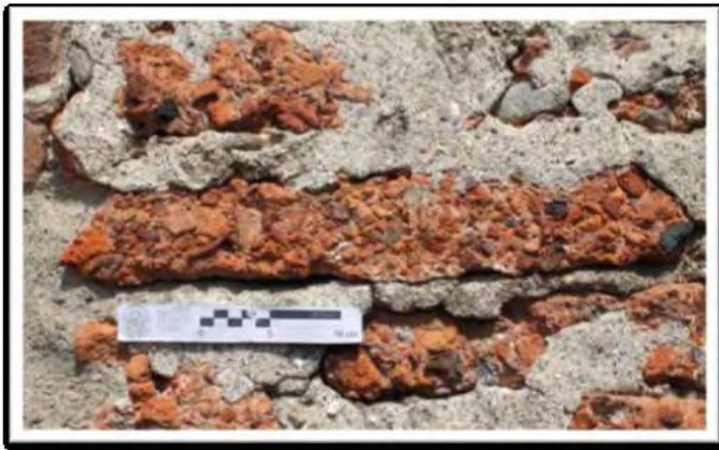
Fig. 185: c.d. Torre del Principe, prospetto occidentale: cocchiopesto reimpiegato nel tamponamento di una finestra.
