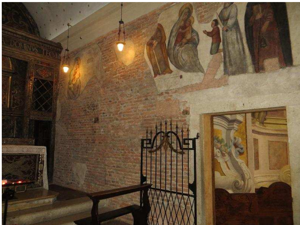
fig. 93. Brescia, Santa Casa presso Santa Maria della Carità, parete est
