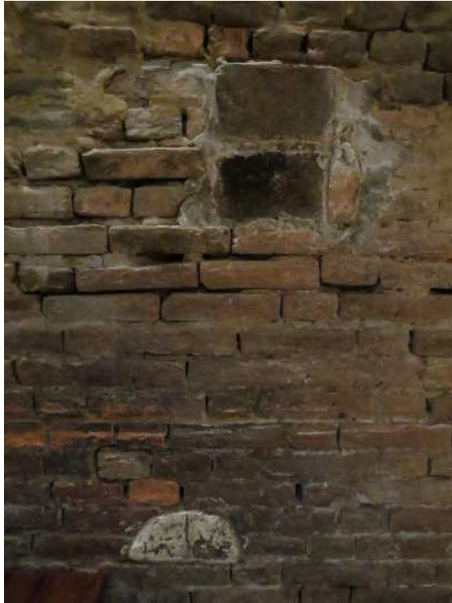
fig. 74. Cremona, Santa Casa presso Sant'Abbondio, parete nord, particolare della muratura
