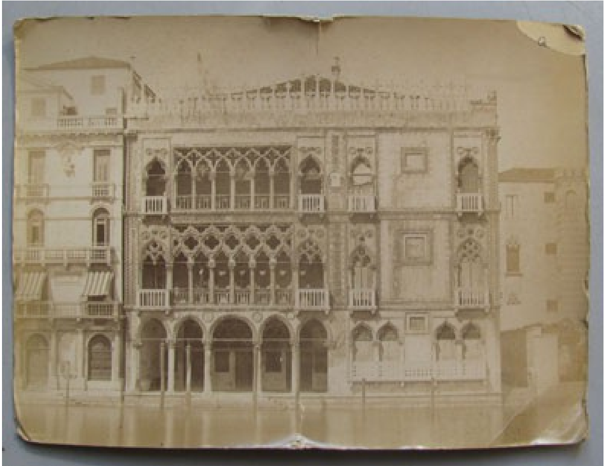
Fig. 28. Il prospetto della Ca' d'Oro dopo il restauro diretto dall'architetto Meduna, (ACV, 1895-1899, IX, 7,3, fotografia G)
