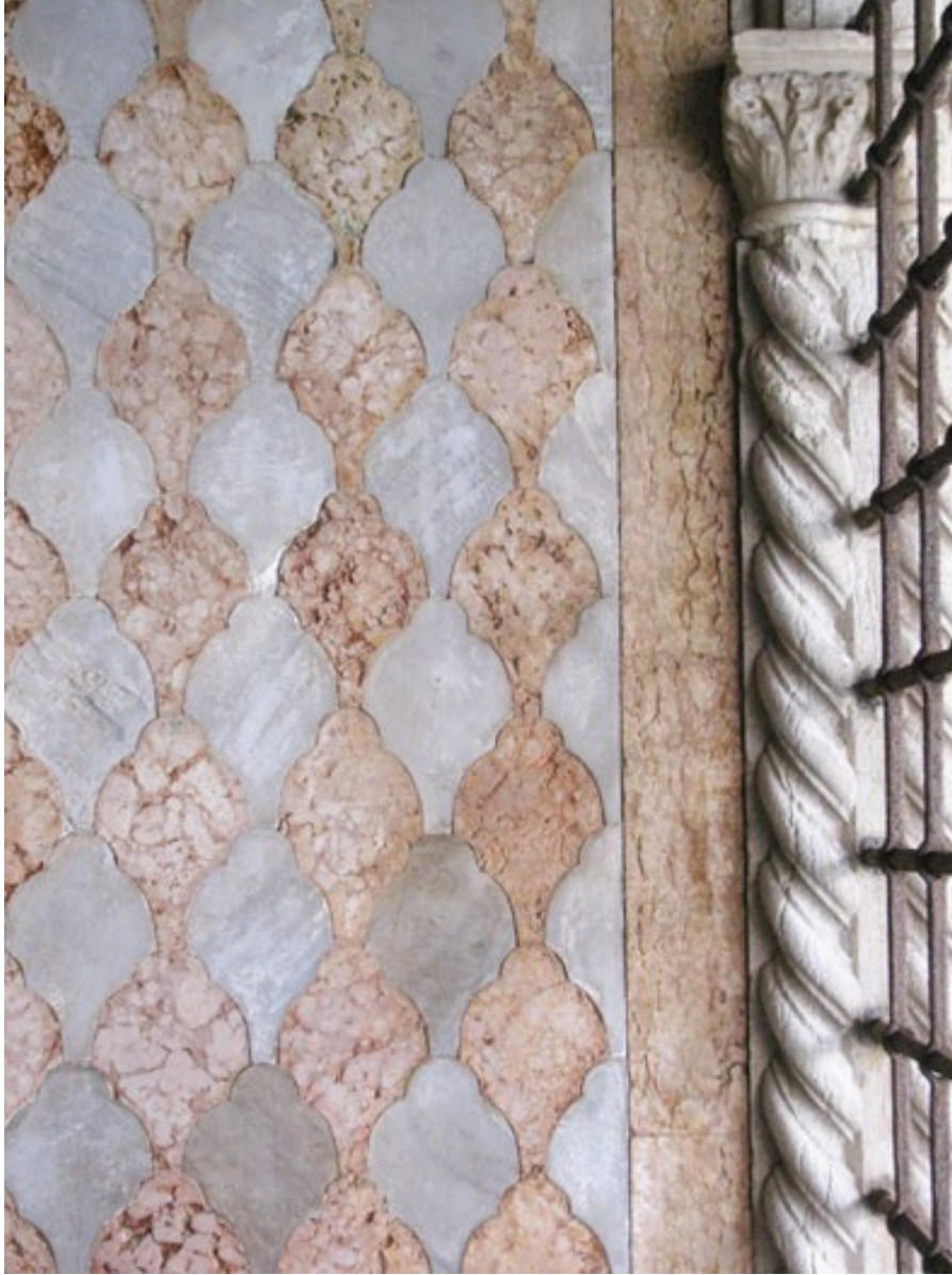
Fig. 54. Ca' d'Oro, dettaglio del rivestimento parietale del piano terreno.
