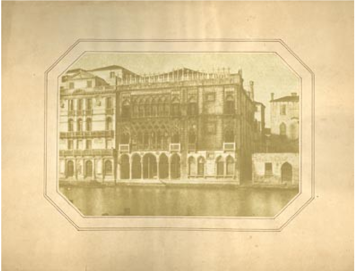
Fig. 26. Fotografia del palazzo durante i lavori diretti dall'architetto Meduna, (BMC, Fondo Dolcetti 42).
