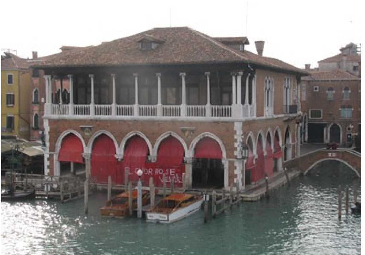
Fig. 46. La Pescheria di Rialto, prospetto sul Canal Grande.
