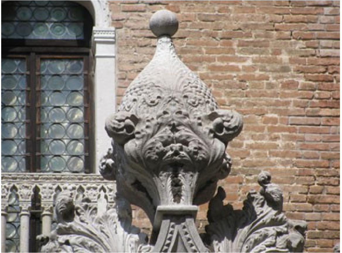
Fig. 44. Dettaglio del coronamento del portale del palazzo sulla calle Ca' d'Oro.
