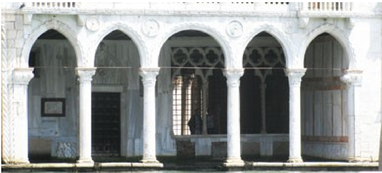
Fig. 24. Ca' d'Oro, la parete retrostante la loggia terrena sul Canal Grande allo stato attuale.
