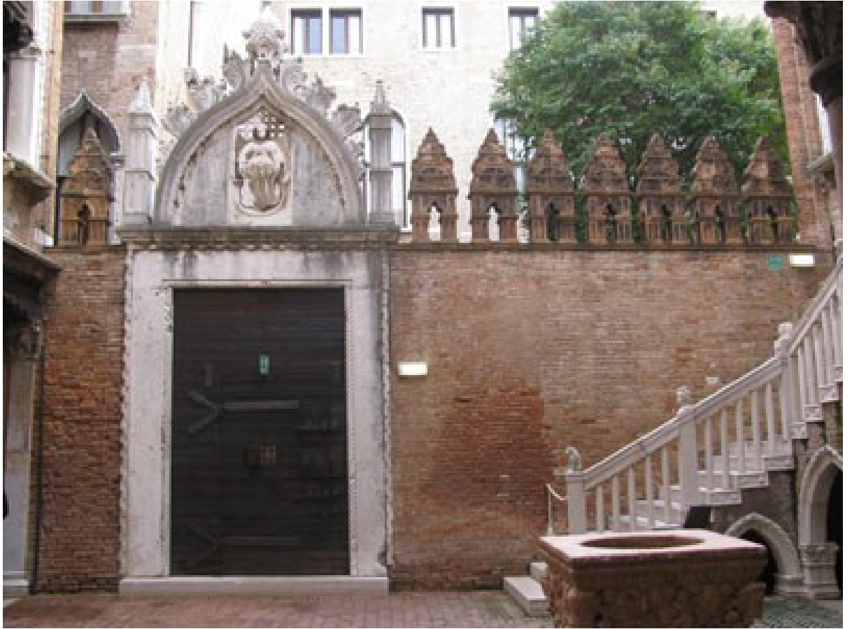
Fig. 8. Ca' d'Oro, veduta complessiva del muro di cinta e della porta di terra dalla corte.
