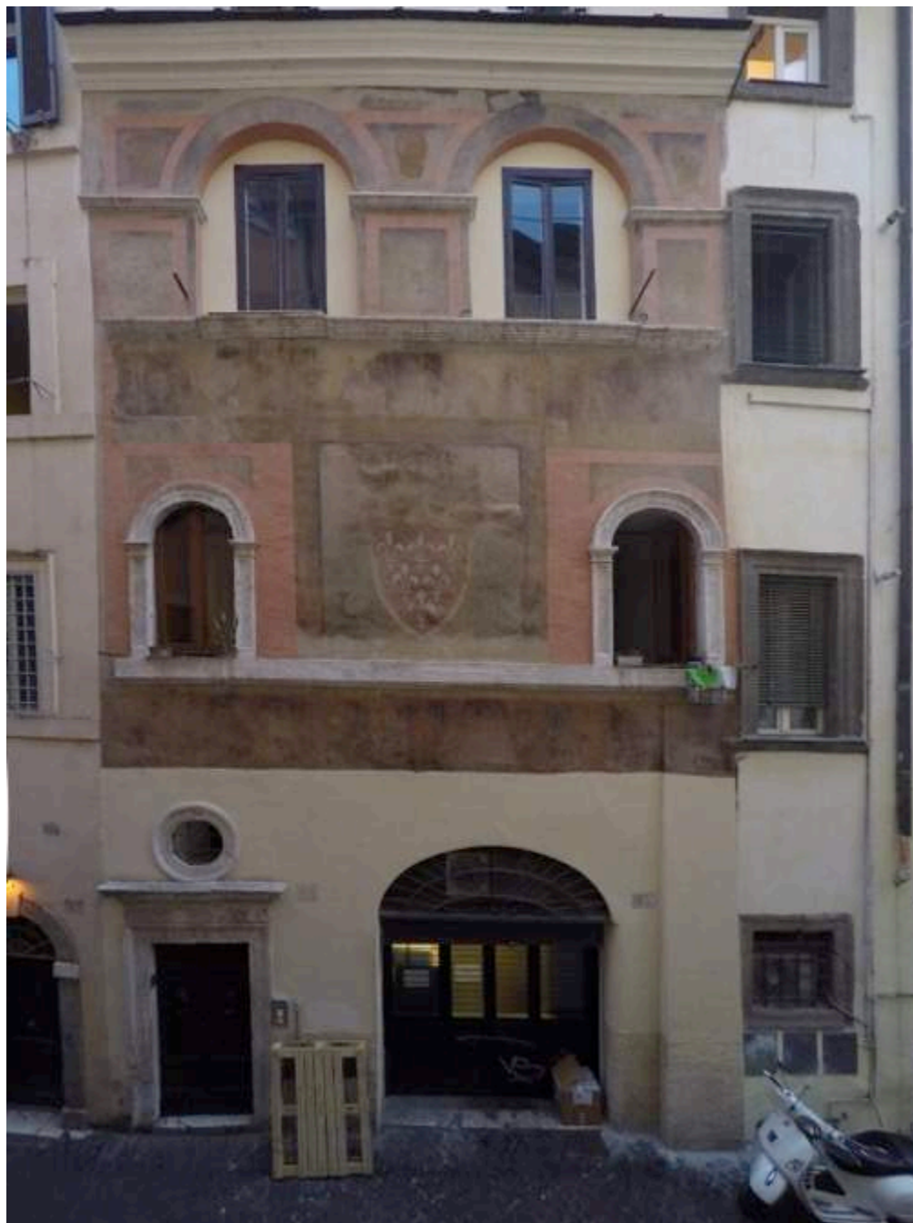
Figura 43. Casa Lancia a via di San Salvatore in Campo 43-44, Roma
