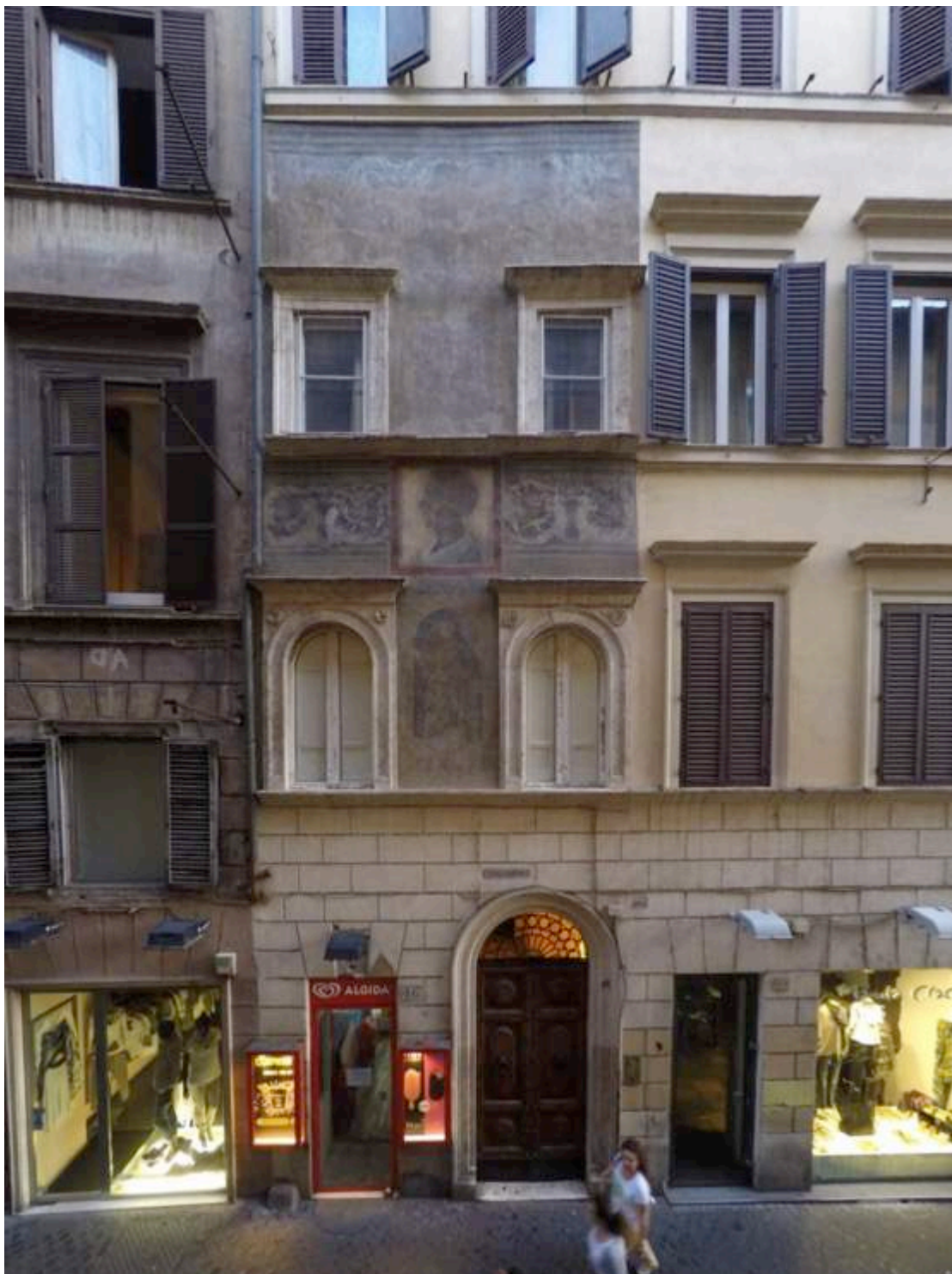
Figura 63. Aspetto attuale della facciata di via dei Giubbonari, 46, Roma
