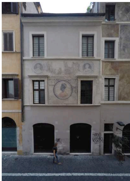
Via del Pellegrino 63-64. Fotografia attuale.
