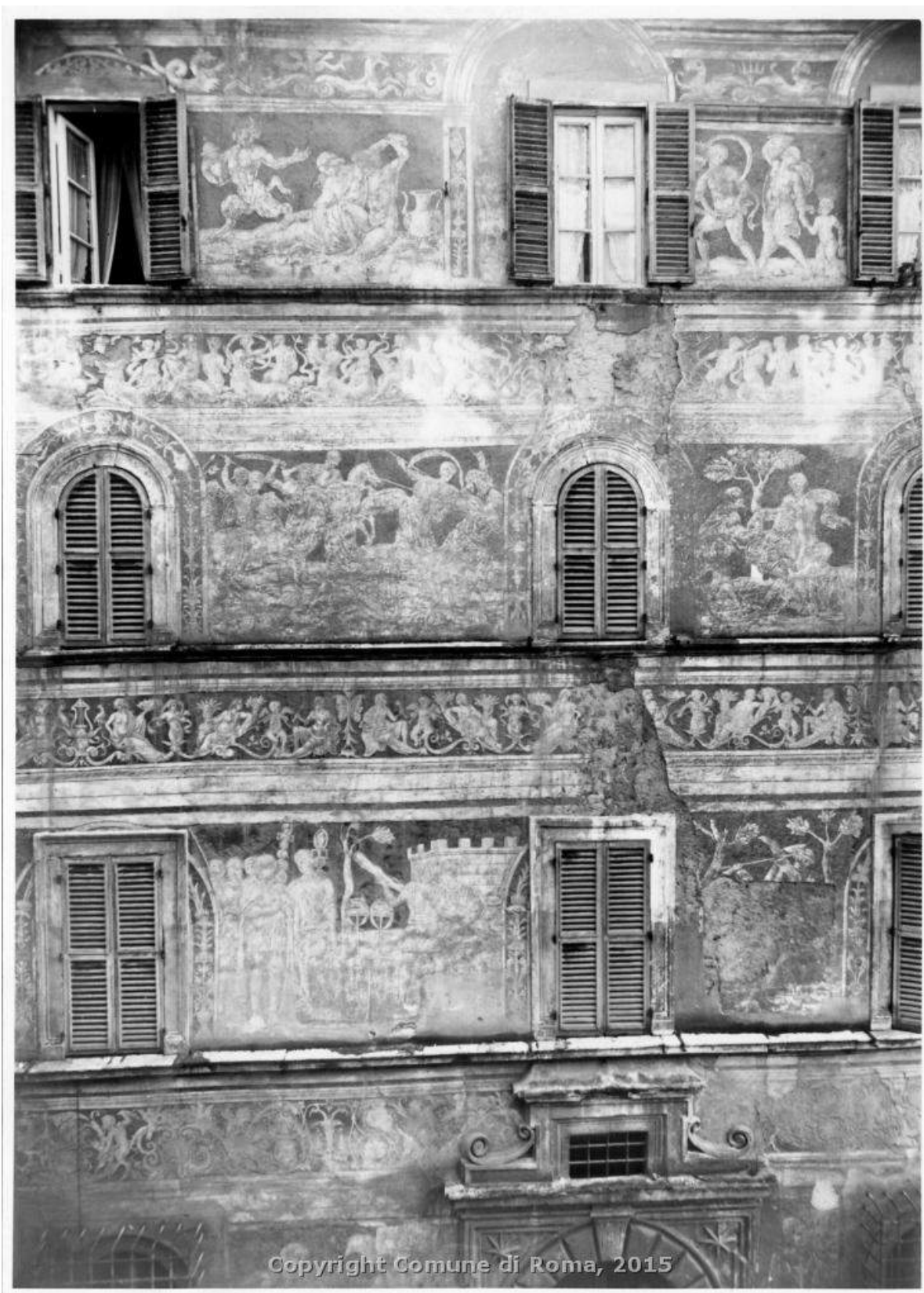
Figura 39. Decorazione a graffito del terzo piano della casa di via della Maschera d'Oro 9. Fotografia del 1960 su gentile concessione del Museo di Palazzo Braschi.
