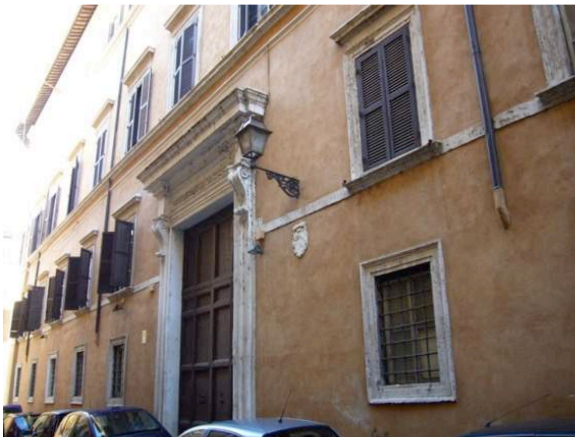
Figura 54. L'aspetto attuale della facciata di Palazzo Gaddi in via della Maschera d'oro, Roma
