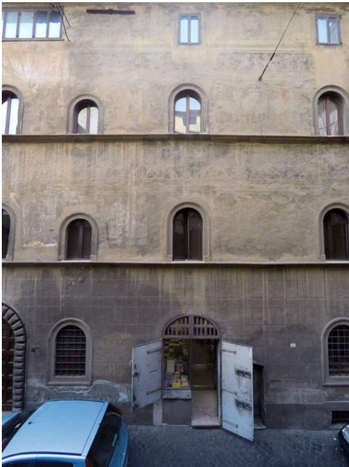
Figura 64. Aspetto attuale della facciata di vicolo del Campanile, 3.
