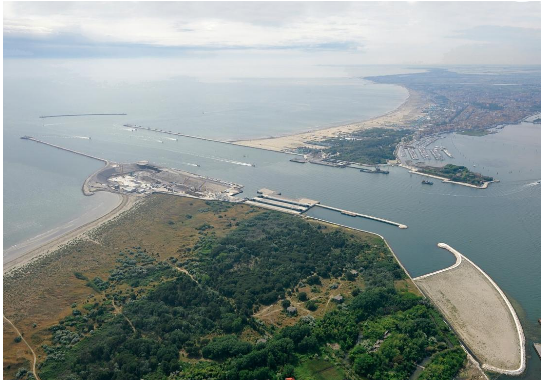
Figure 6. Vue aérienne des travaux du MOSE à l'embouchure de Chioggia. Consorzio Venezia Nuova, 2013
