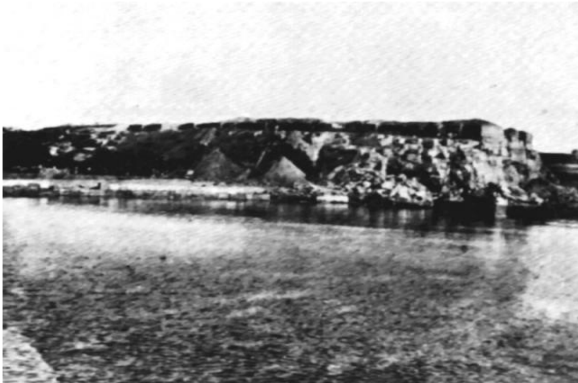
Figura 13: Scoglio del Tonno fotografato nel 1888, prima dei lavori di demolizione iniziati l’anno seguente in seguito ai quali avvenne la scoperta del sito preromano.
