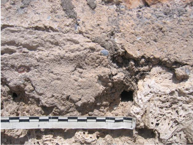
**Fig. 69. Esempio di malta spalmata esterna (ES 1445).**
