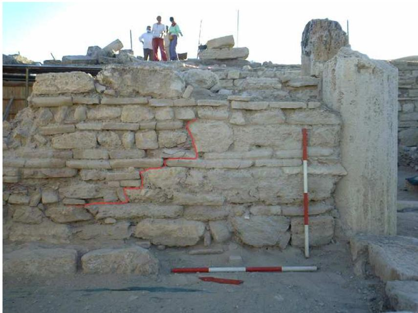
Fig. 48. Tecnica 3c, muro ES 1200 (A 1201, Casa del cortile dorico).
