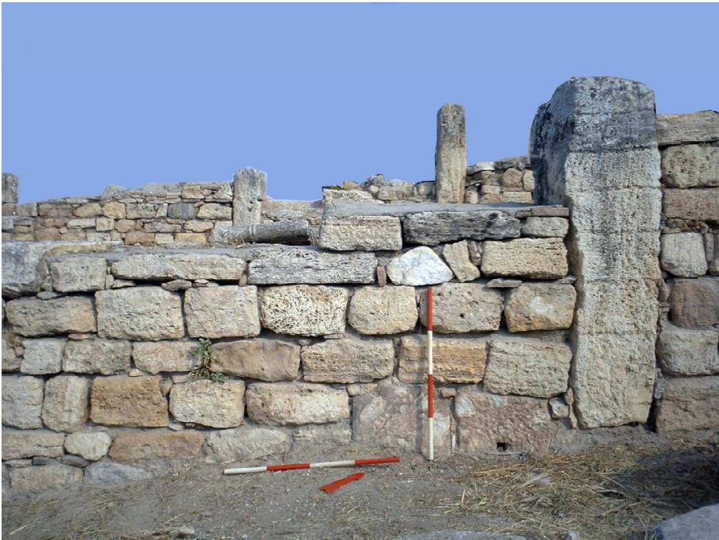
**Fig. 20. Muro 4 (stenopos 19, Casa dei capitelli ionici) con elementi di reimpiego nel primo corso inferiore, tra cui un concio con incavo quadrato..**
