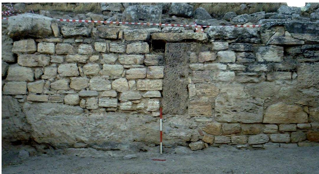
**Fig. 31. Muro ES 90 (A 115, Casa del cortile dorico), costruito con la Tecnica 2, munito al centro del paramento di una catena verticale per dare maggiore solidità alla struttura.**
